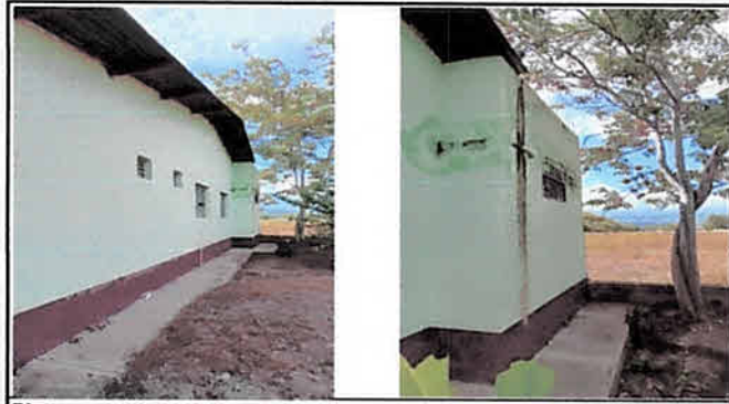
Pintura en muros interiores y exteriores.
