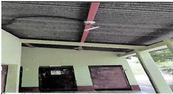
Reparación de sistema eléctrico.
