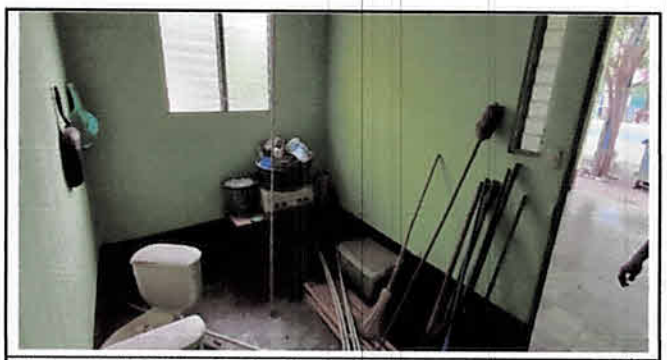
Fabricación de Mesón, Sustitución de Piso, Estufa Rural.
