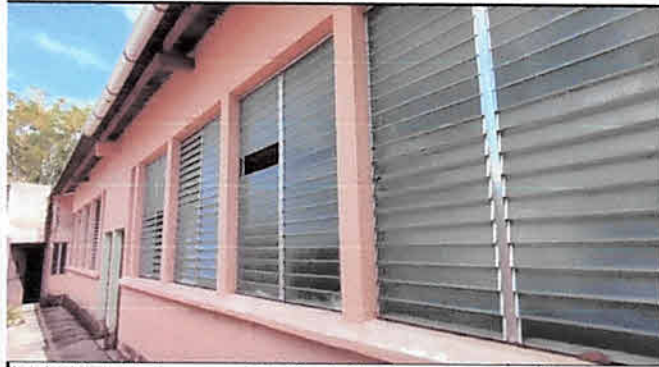
Instalación de Balcones, sustitución de Canal para agua pluvial.
